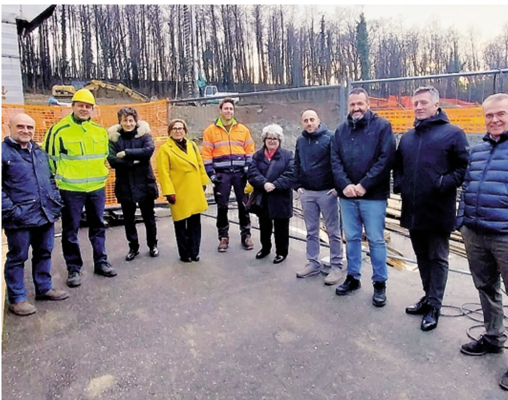
Visita al cantiere Silea, il terzo da sinistra è il direttore Pietro Antonio D'Alema, accanto la presidente Rota
